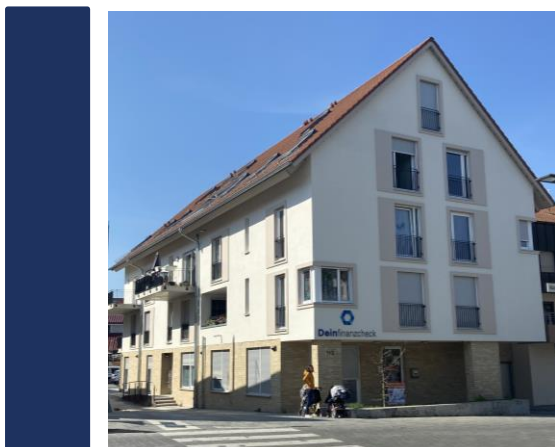
Wohnanlage in Kernen im Remstal
