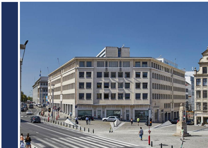
Objekt Brüssel, Boulevard de L'Empereur 3-5
