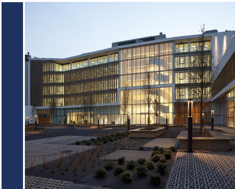
Foto Objekt Mailand: © Jones Lang LaSalle
